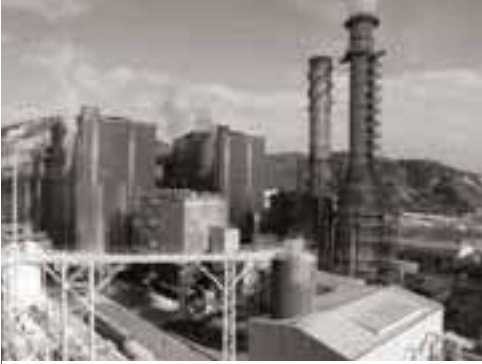
Bolu Göynük Termik Enerji Santrali
