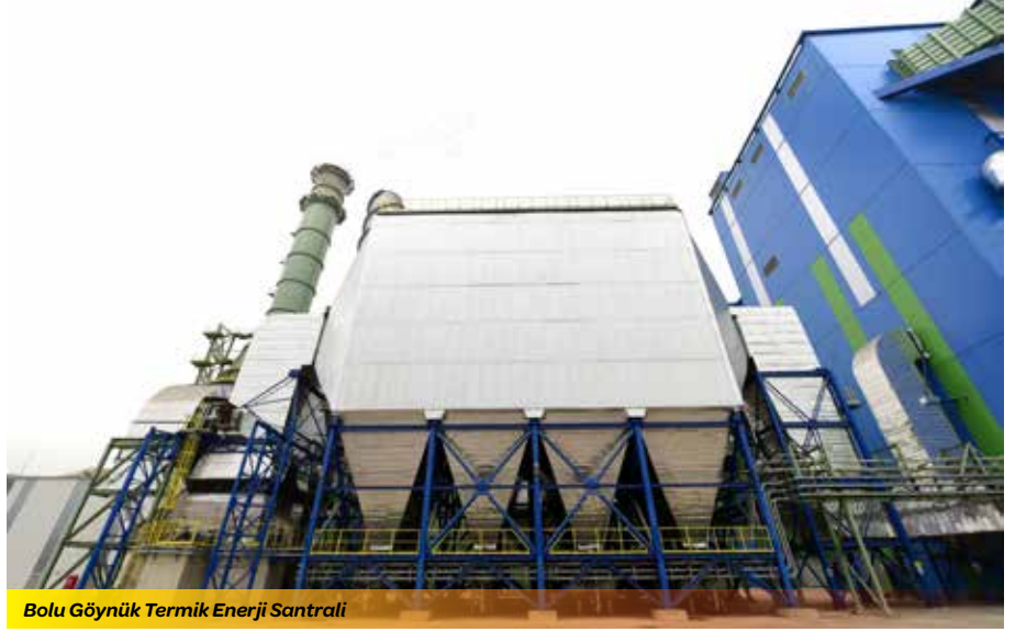
Bolu Göynük Termik Enerji Santrali
