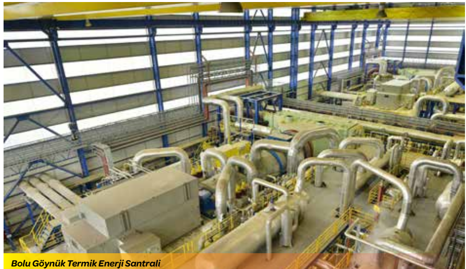
Bolu Göynük Termik Enerji Santrali
