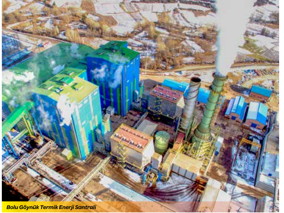
Bolu Göynük Termik Enerji Santrali
