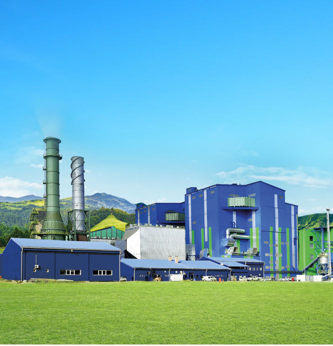
Bolu Göynük Termik Enerji Santrali
